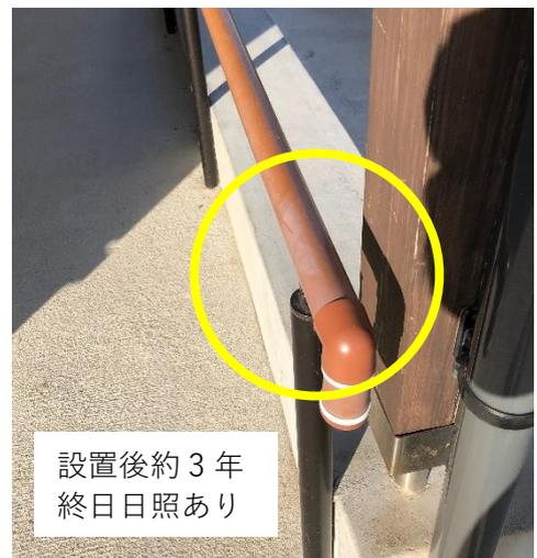
ですが最近では、手すり素材も耐候性の高い素材の開発に加え、木目調の模様をつけ表面の劣化を目立ちにくくするなどの工夫もなされています。
